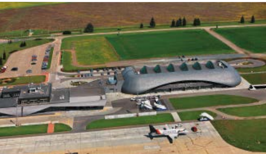
Stavba roku 2007 – odbavovací hala letiště v Brně-Tuřanech
