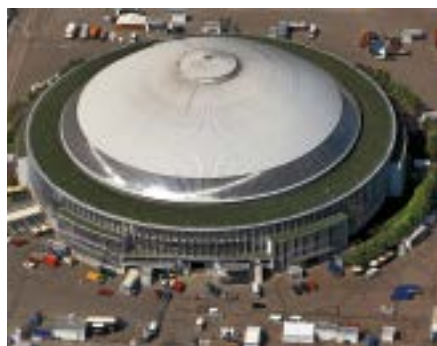
Pavilon „Z“ má průměr přes 120 m, kopule je vysoká 46 m
